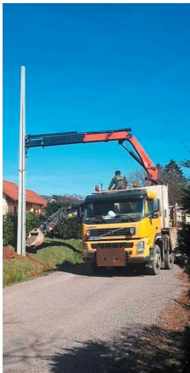
Dans le secteur des Granges, des lignes électriques ont été déplacées pour être repositionnées en bord de voirie, afin qu'un éclairage public puisse être assuré dans cette zone (rue de l'Esprit, rue des Granges et partie basse de la rue des Étangs).
